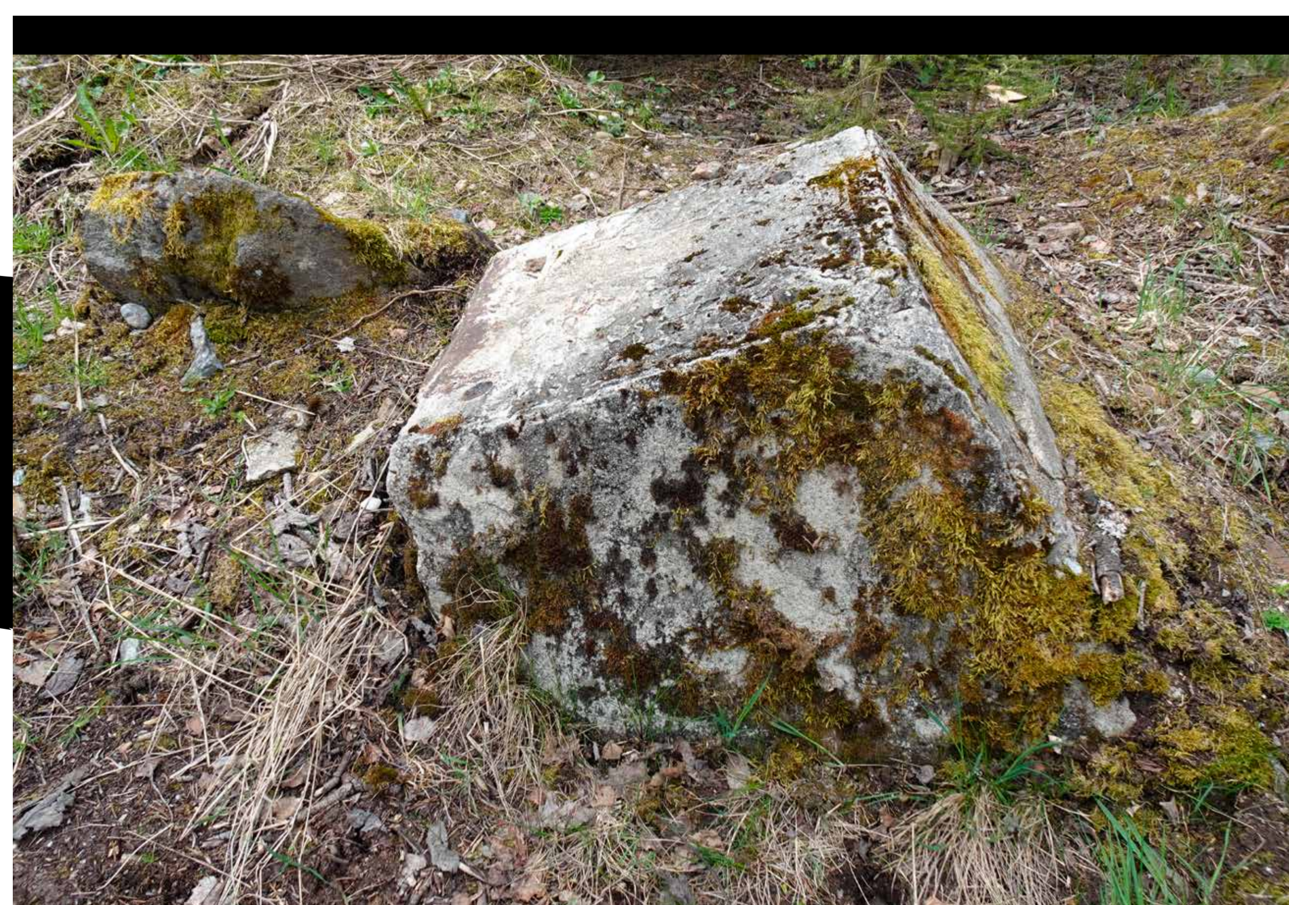
ZLEVA: BETONOVÉ PATKY TĚŽNÍ VĚŽE U DOLU ROVNOST. BÝVALÁ STRÁŽNICE U UJEZDU DO AREÁLU ROVNOSTI. ČERPACÍ STANICE NA VODU S NÁDRŽÍ. FOTO: MICHAL LOUČ
